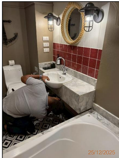
รูปภาพที่ 2.4 การตรวจสอบระบบท่อน้ำ ก๊อกน้ำและสุขภัณฑ์
