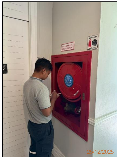
รูปภาพที่ 2.5 การตรวจสอบระบบป้องกันอัคคีภัยและระบบเตือนภัย
