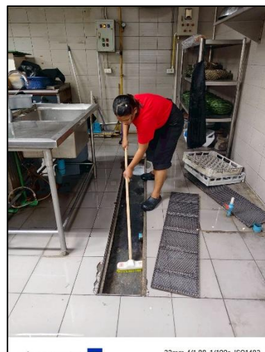
รูปภาพที่ 2.11 การขุดลอกตะกอนในท่อน้ำ
